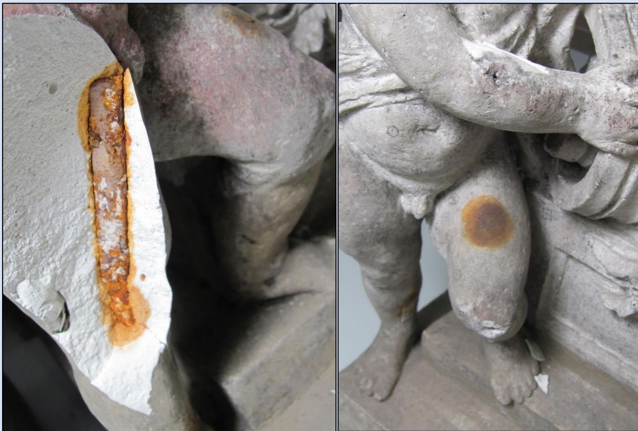
Mechanismus šíření produktů koroze kovů, praskání vlivem nárůstu objemu
