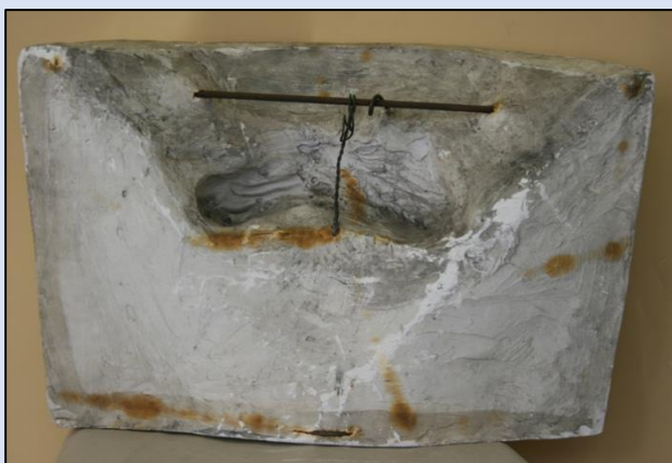
Kotvení za nosnou konstrukci
