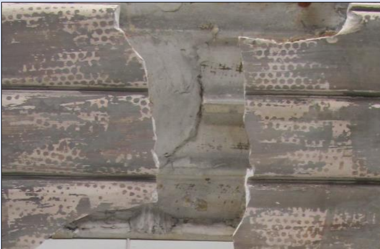
Důsledek vysrážení vlhkosti pod bublinkovou fólií při delší expozici
