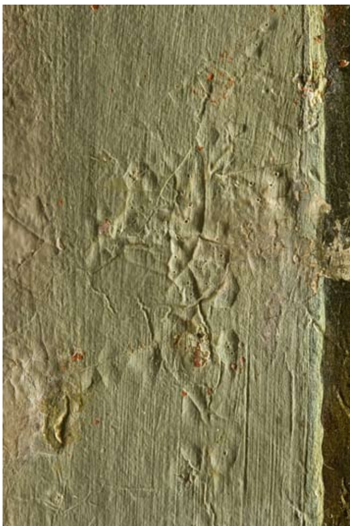
15. Detail uvolněné malby v partiích šedého orámování před restaurováním, boční osvětlení (foto A. Pokorný)
