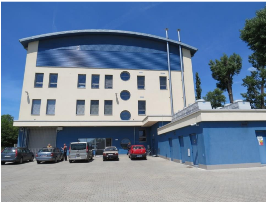
Depozitář Moravské galerie v Brně (na zelené louce)
